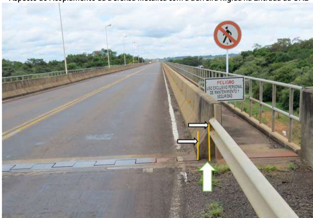
Aspecto do Acoplamento da Defesa Metálica com a Barreira Rígida na Entrada da OAE
