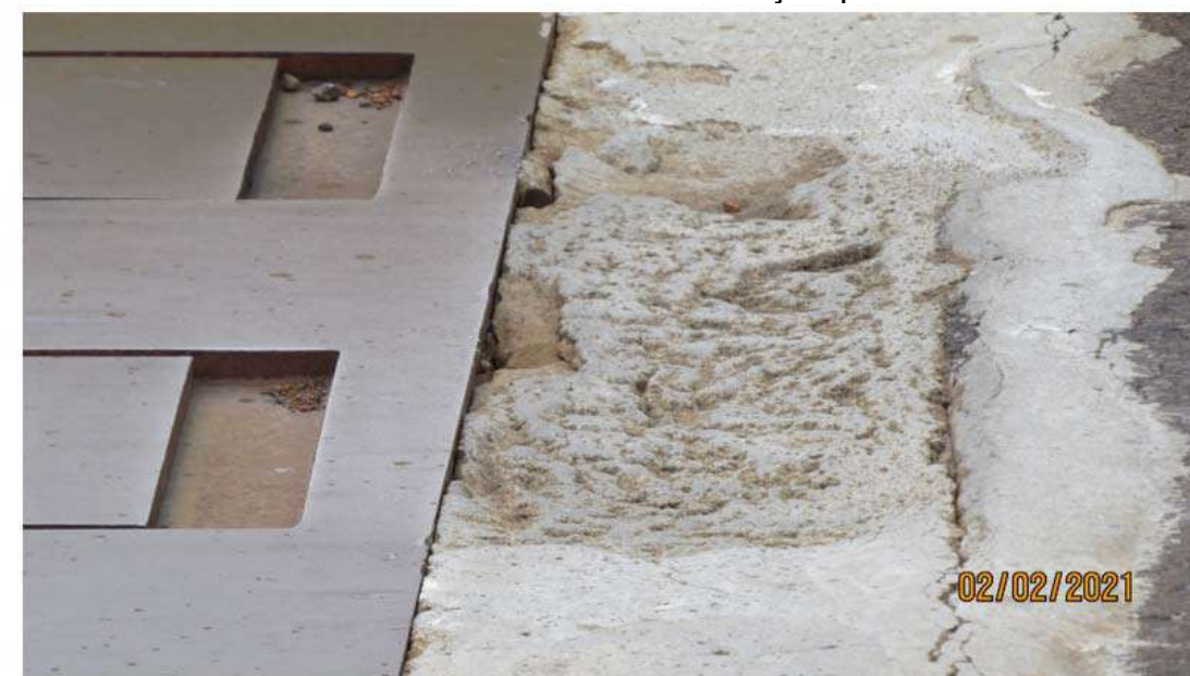
Detalhe do Defeito da Junta de Dilatação Apoio 16
