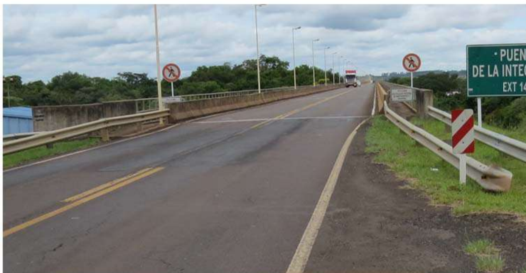
Detalhe do Pavimento Sobre a Laje de Aproximação no Acesso Argentino da OAE
