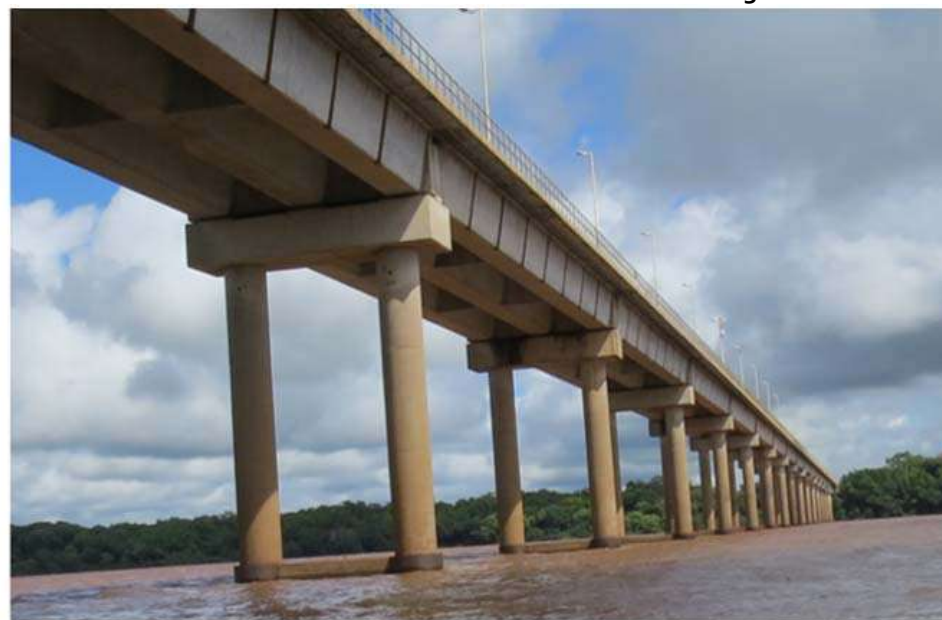
Vista de Pilares Posicionados no Leito do Rio Uruguai
