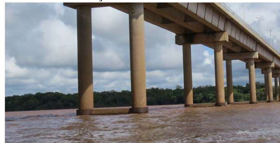
Vista de Vigas de Travamento e Pilares no Leito do Rio
