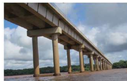
Observa-se que no leito do rio as vigas se apresentam em bom estado.
