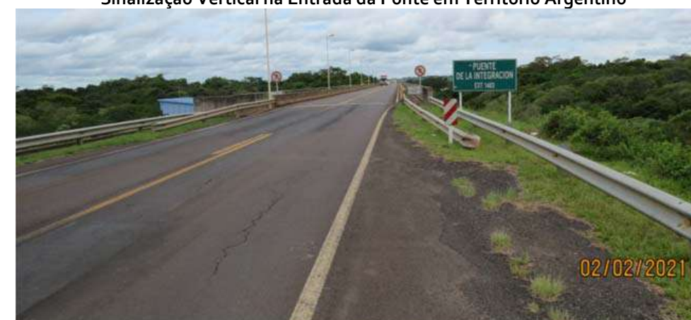
Sinalização Vertical na Entrada da Ponte em Território Argentino
