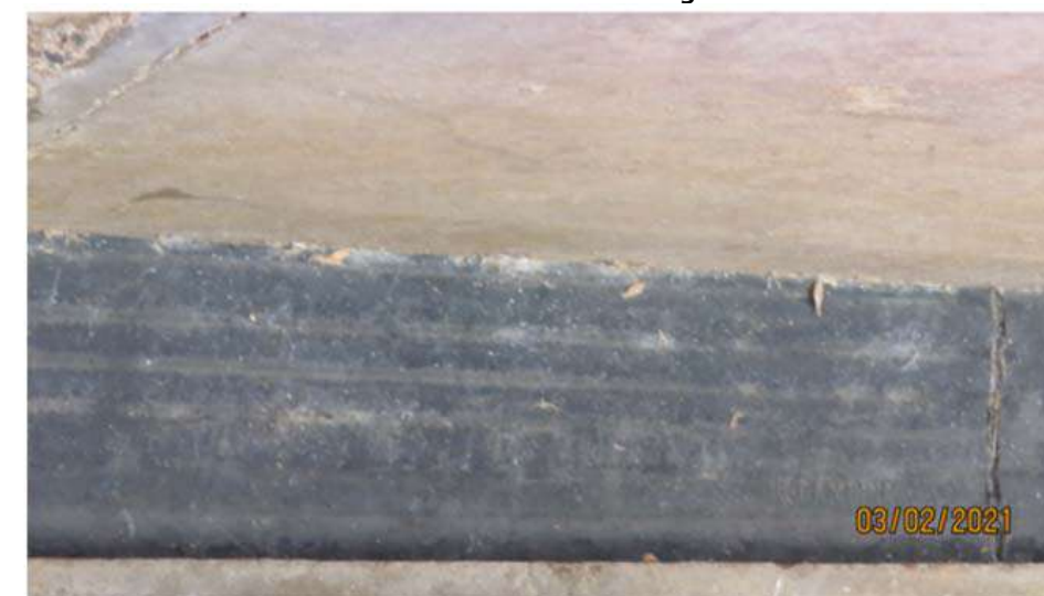
Aspecto de Um dos Aparelhos de Apoio da Viga 2, sobre o Pilar 1, no Mesmo Encontro na Extremidade Argentina da Ponte
