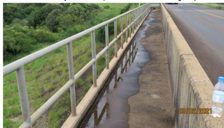
Vista de Parte da Calçada da Ponte, Mostrando Acúmulo de Água Após Chuva
