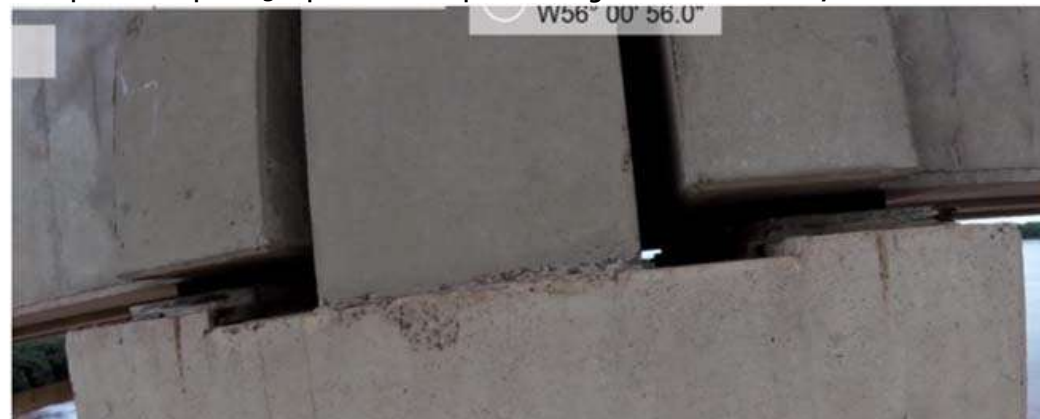
Aspecto do Apoio 13: Aparelhos de Apoio das Vigas Laterais Direitas, Sentido AR-BR
