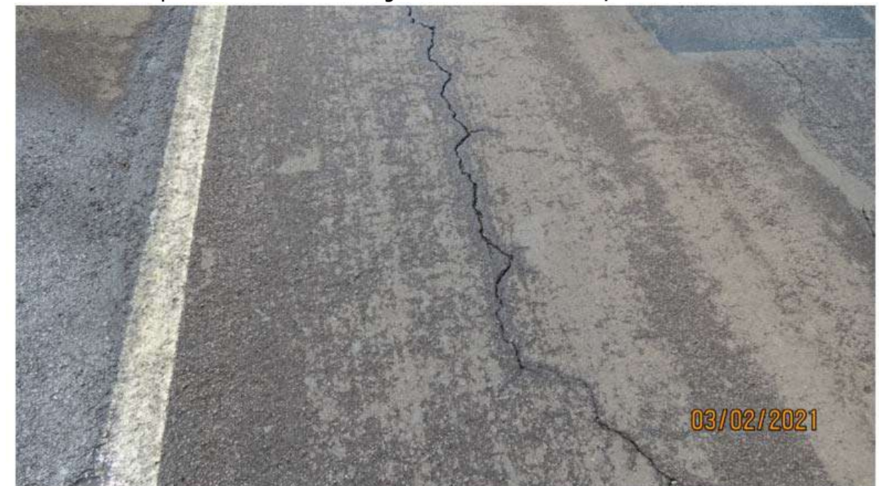
Aspecto do Pavimento na Chegada ao Encontro da Ponte, Sentido ARG-BR
