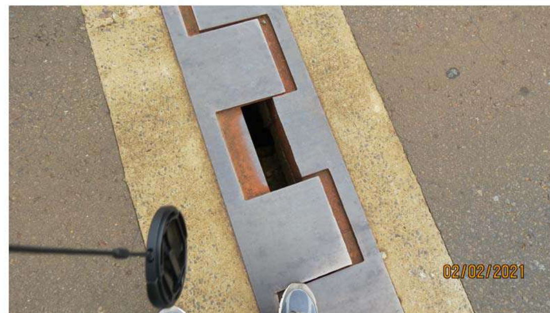
Junta de Dilatação Sobre o Apoio 02, com Necessidade de Reparo Devido a Quebra na Chapa
