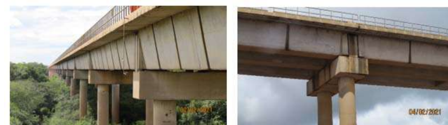
Vigas Longarinas ao Longo da OAE
