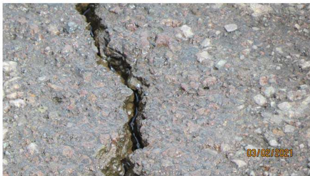
Detalhe do Pavimento
