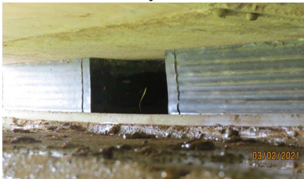
Aspecto dos Aparelhos de Apoio da Viga 3, sobre o Pilar 1, no Mesmo Encontro na Extremidade Argentina da Ponte
