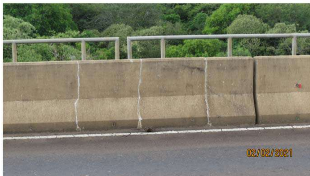
Reparo de Trinca nas Barreiras Rígidas
