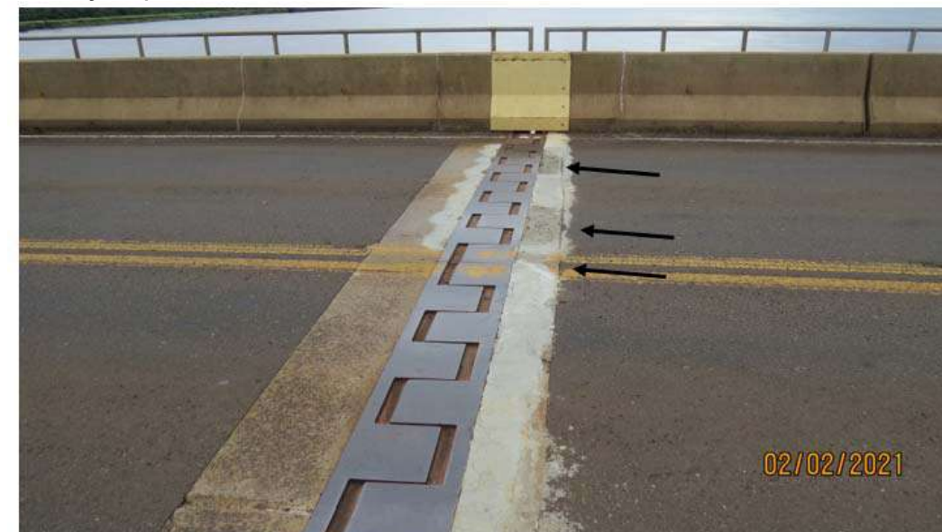
Junta de Dilatação Apoio 16: Defeito no Concreto de Concordância Pavimento/Metals da Junta de Dilatação
