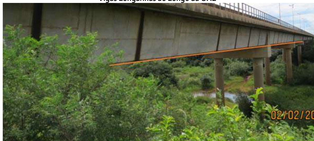
Vigas Longarinas ao Longo da OAE
