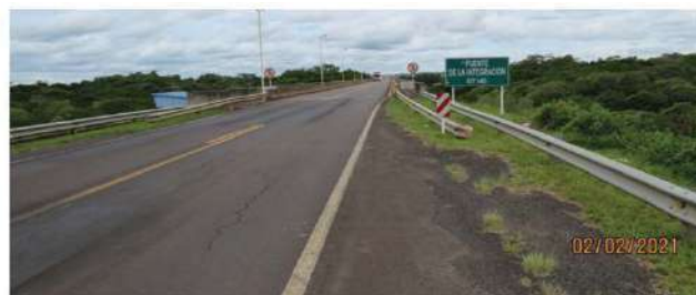
Sinalização Vertical no acesso a ponte em território Argentino
