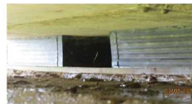
Aparelho de apoio no sob vigas no encontro nº1, na Argentina.
