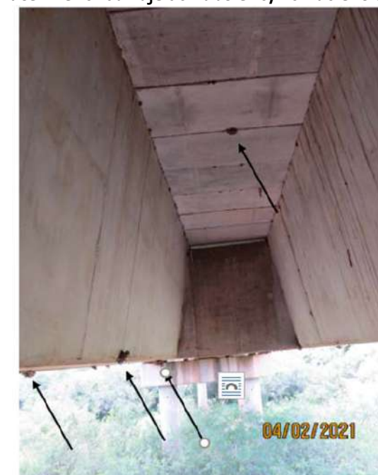
Aspecto da Face Inferior da Laje do Tabuleiro, no Vão entre os Apoios 1 e 2
