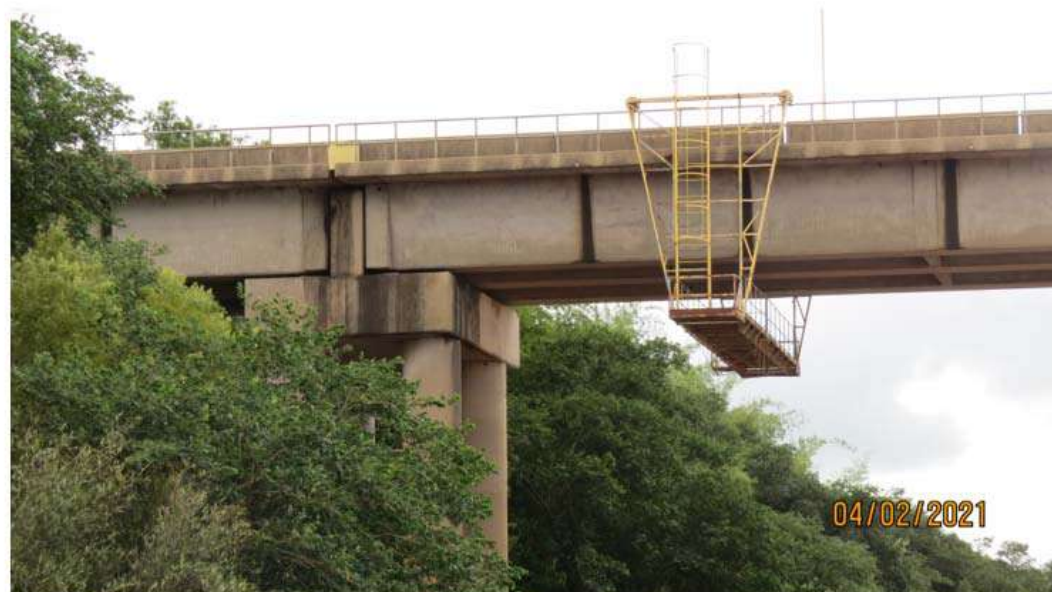
Vista dos Pilares de Apoio 8, Mostrando a Viga Travessa da Cabeça dos Pilares, em Forma de Bloco
