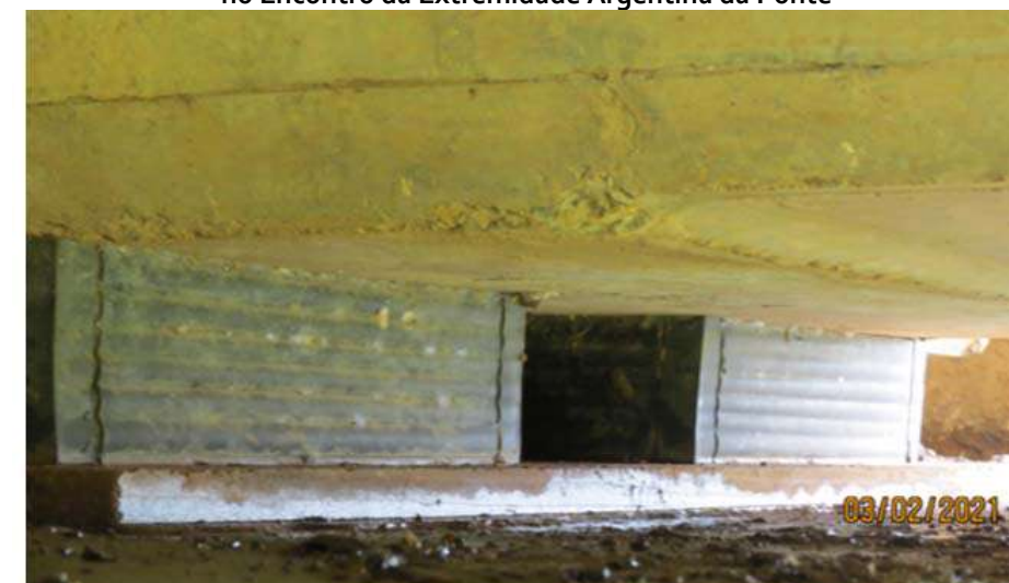
Aspectos dos Aparelhos de Apoio da Viga 1, sobre o Pilar 1, no Encontro da Extremidade Argentina da Ponte
