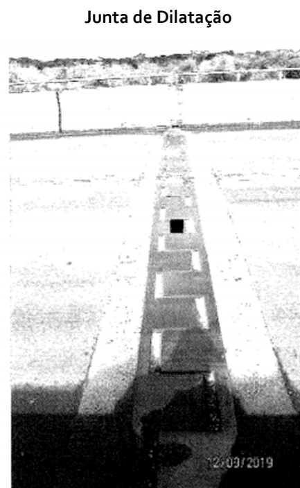
Foto 36 – Ponte – Junta Danificada
