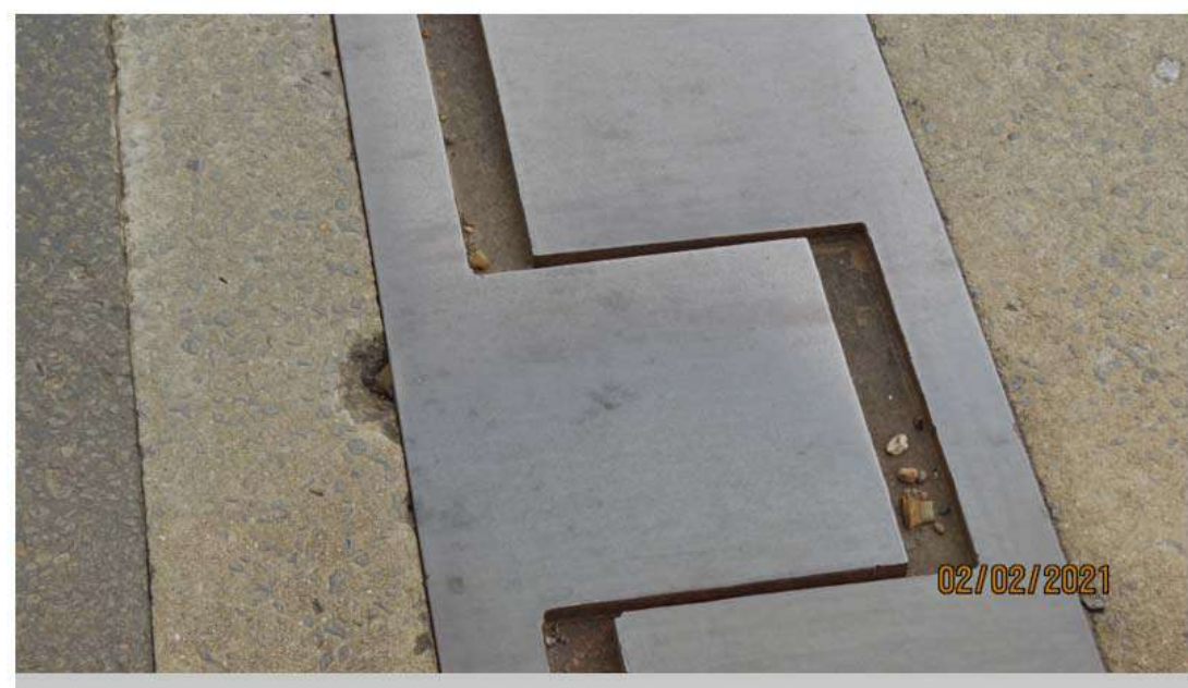
Junta de Dilatação com Necessidade de Limpeza
