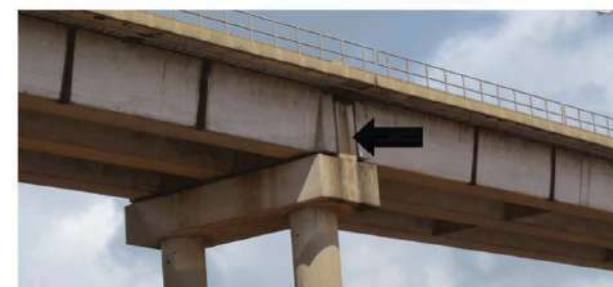
Esta foto, apresenta uma viga no leito do rio. No destaque observa-se um pilarete auxiliar, utilizado na época da construção, onde eram apoiados os perfis metálicos de deslocamento lateral e longitudinal, da treliça lançadeira de vigas pré-moldadas.
