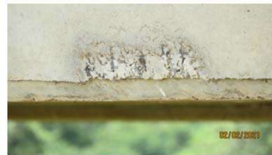
Viga Longarina 99, no Vão 33, em Território Brasileiro
