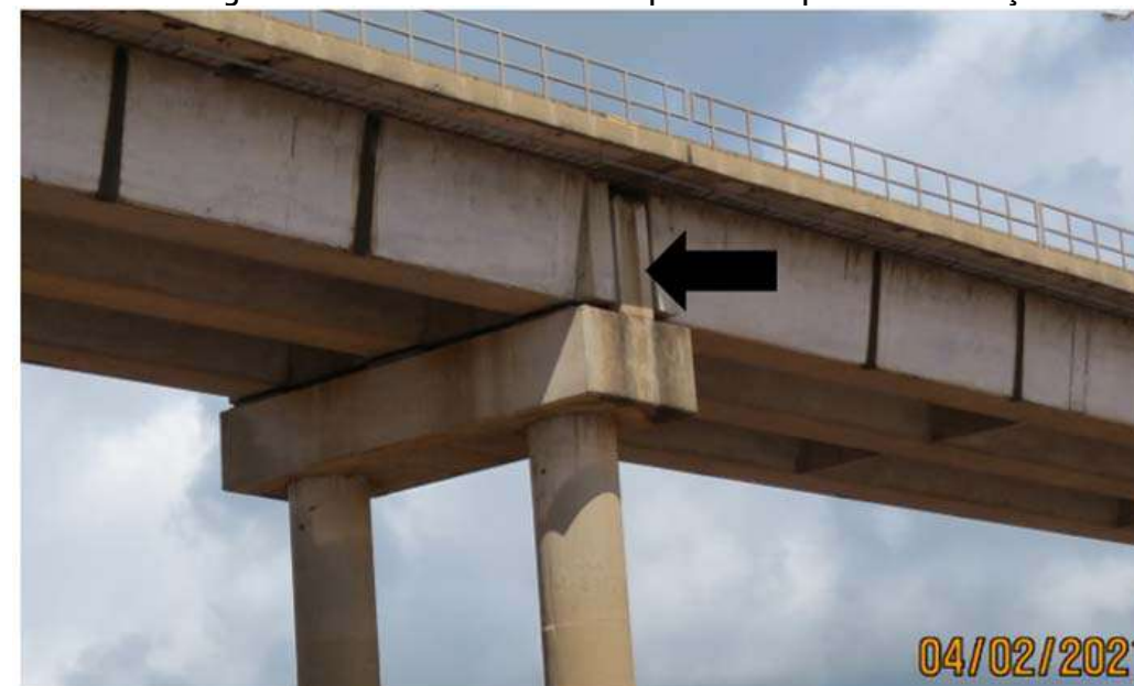
Vista de Uma Viga Travessa com Um Pilaretes Disponível na Época da Construção da Ponte
