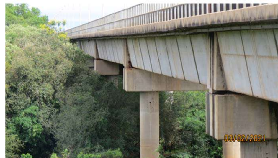
Vista de Pilares Próximos ao Encontro 1, no Encontro com a Ponte, na Argentina
