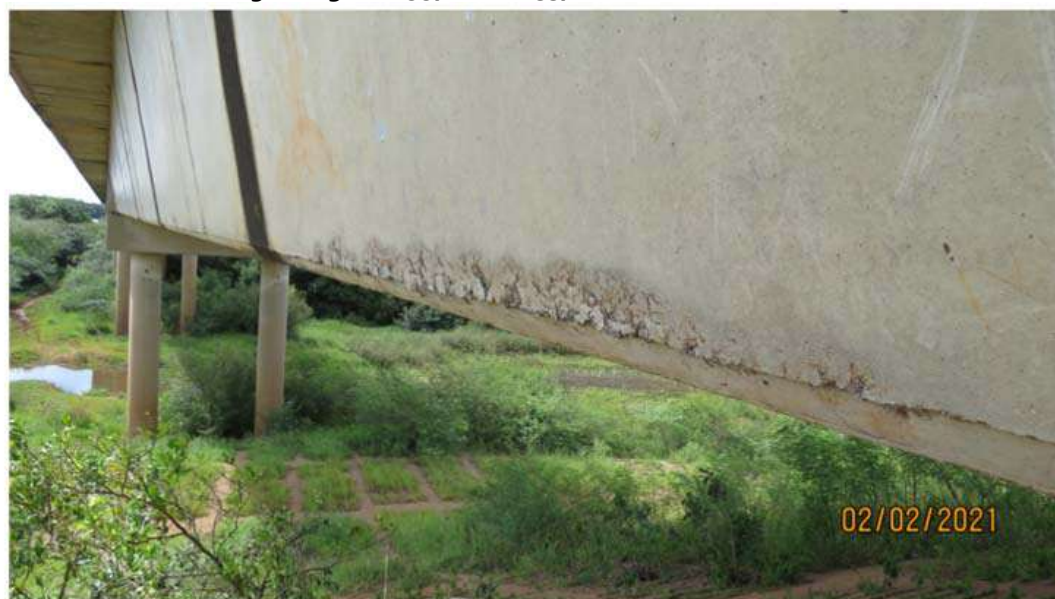
Viga Longarina 99, no Vão 33, em Território Brasileiro
