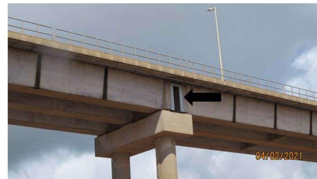
Abertura Numa das Vigas Travessas
