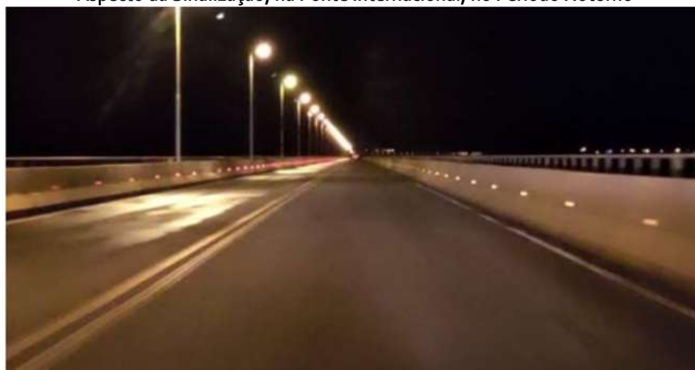
Aspecto da Sinalização, na Ponte Internacional, no Período Noturno
