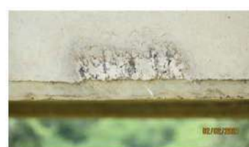
Defeito na concretagem
