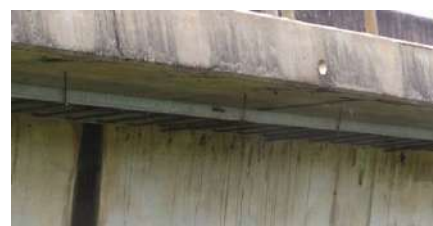
Calhas de energia
