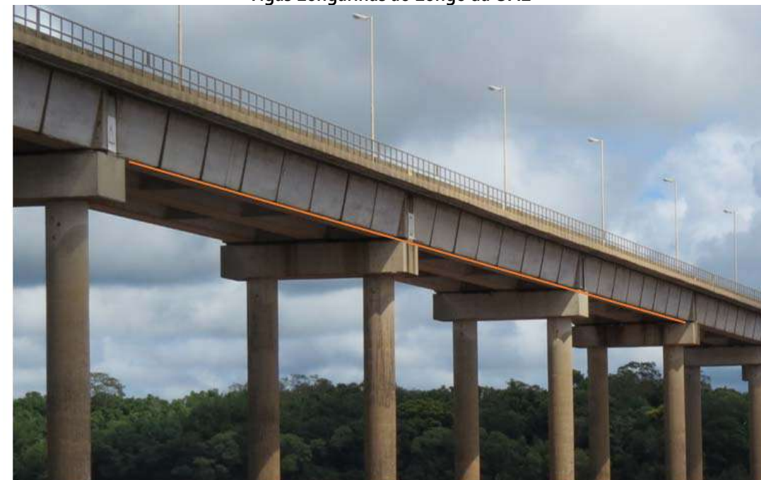
Vigas Longarinas ao Longo da OAE
