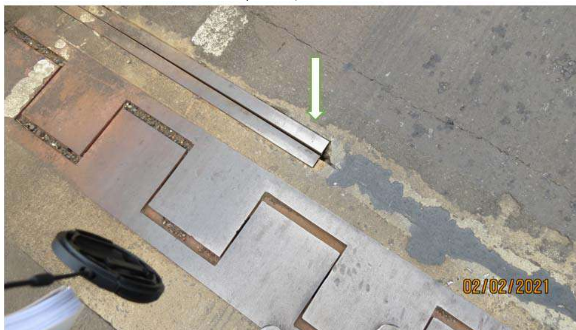
Junta Sobre o Apoio nº 1, Perfil "L" se Soltando
