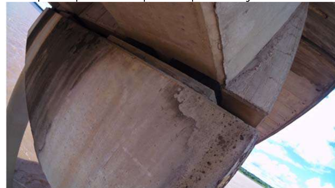
Aspecto do Apoio 12 e Um dos Aparelhos de Apoio de Uma Viga sobre o Pilar 12
