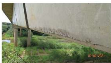
Viga Longarina 98, no vão 33
