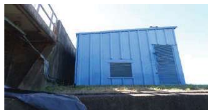
Cabine de Alimentação
