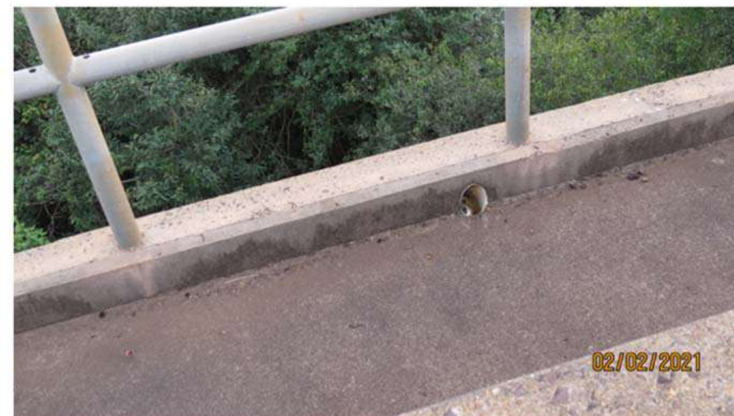
Vista de Parte da Calçada da Ponte, Mostrando Tubo de Saída Limpo
