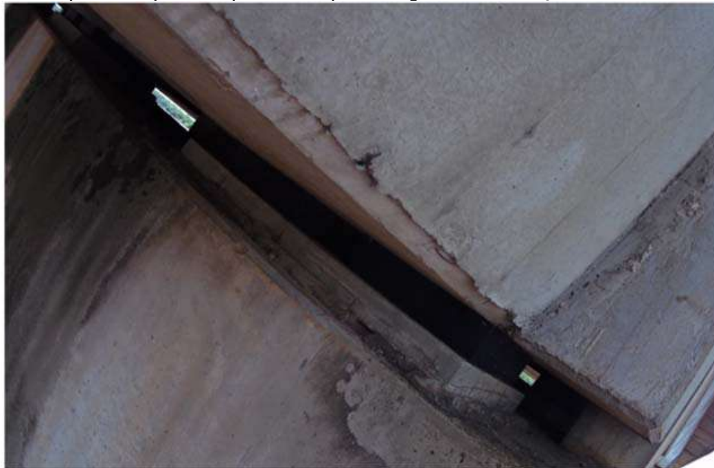
Aspecto do Apoio 12: Aparelho de Apoio da Viga Lateral Direita, sentido AR-BR
