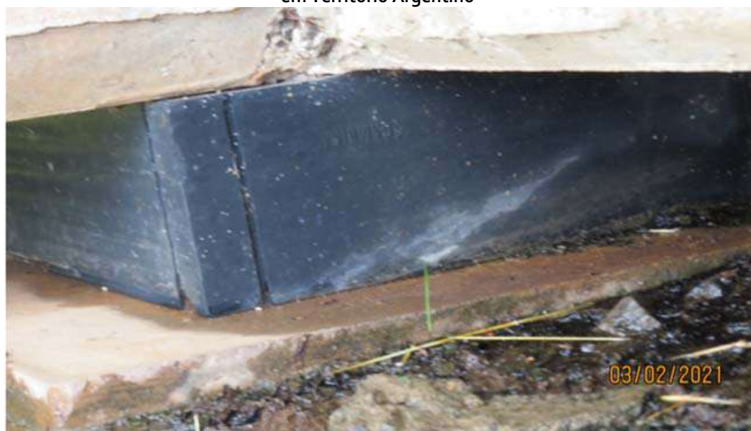
Aspecto de um Aparelho de Apoio da Viga nº 1, sobre o Pilar 1, no Encontro da Ponte, em Território Argentino
