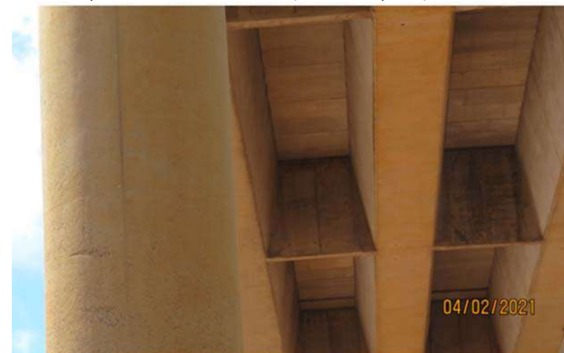
Aspecto da Face Interior do Tabuleiro, Próximo ao Apoio 12, no Leito do Rio
