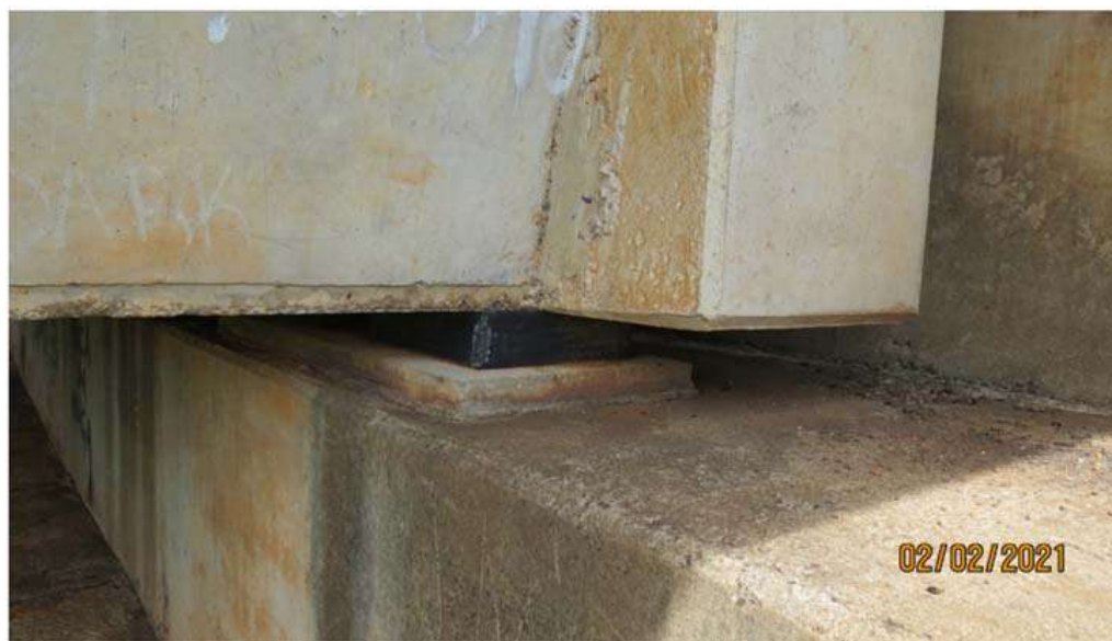
Aspecto de Um dos Aparelhos de Apoio de Uma Viga sobre o Pilar 34, no Encontro da Extremidade Brasileira da Ponte
