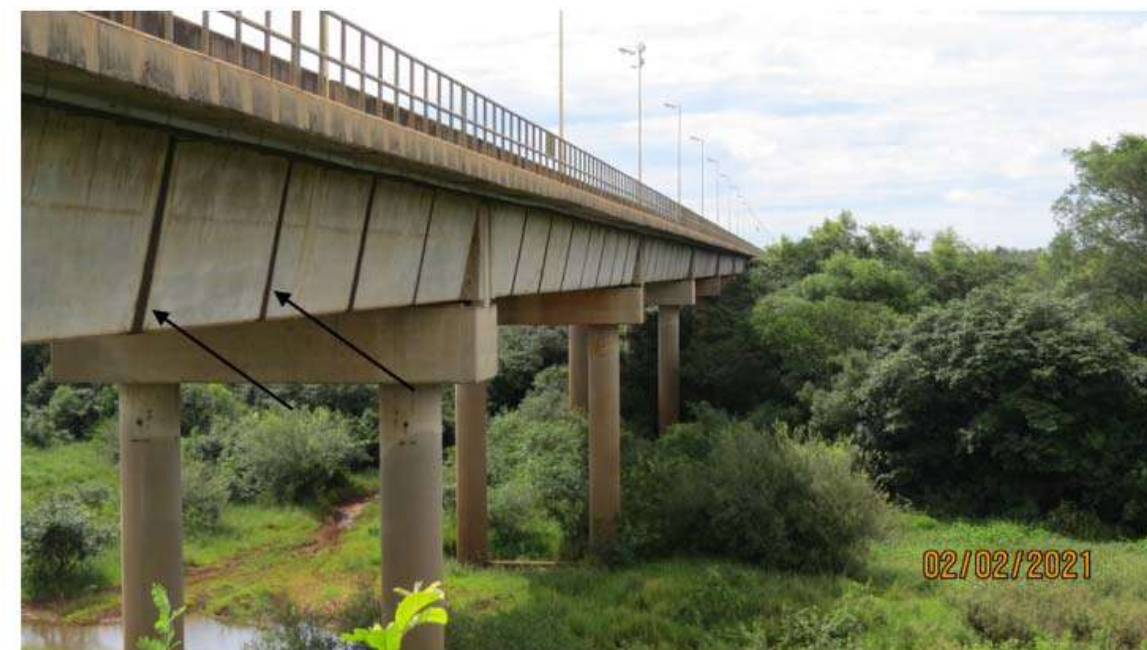
Lateral de Viga Longarina Manchada por Água Devido à Solução Escolhida para a Drenagem do Tabuleiro
